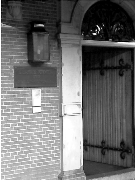
toegangsdeur Eerste Kamer der Staten-Generaal, Binnenhof, Den Haag
